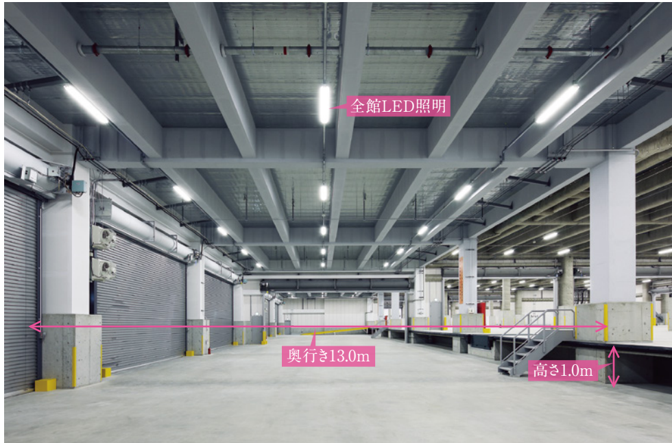
トラックバース □ ドックレベラー：各階6基(1階10基)
