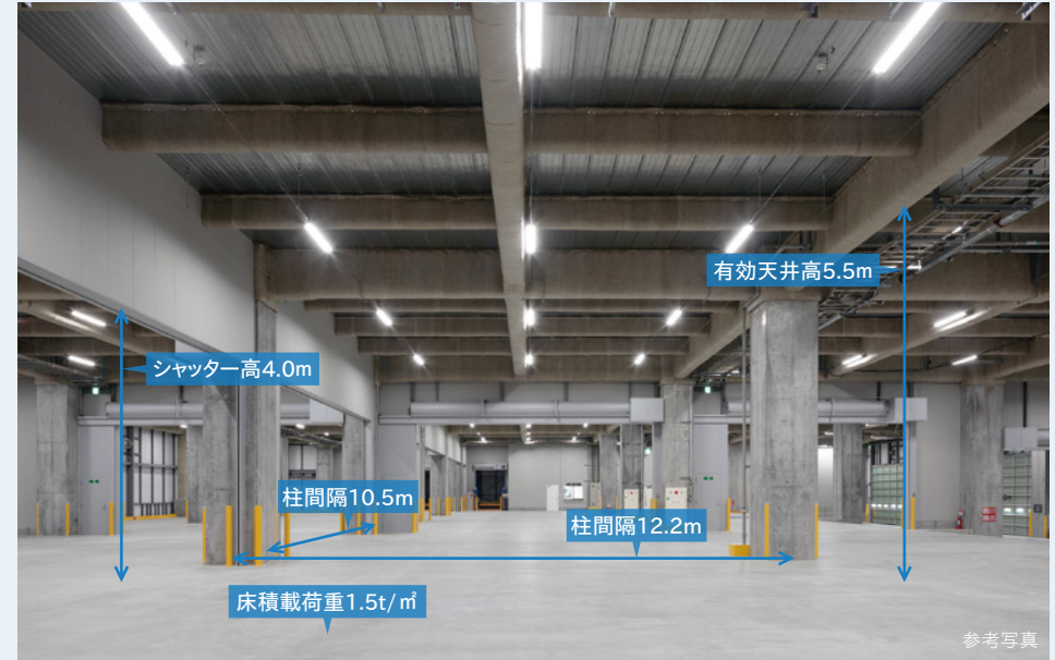
■倉庫 □照明：平均照度250lx(床面)以上
