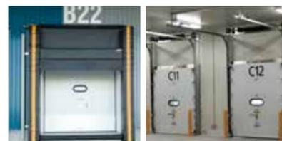
トラック後部の扉を開けて入口に密着させ、室内側からシャッターを開放し、荷物の出し入れ作業を行います。入出庫時に外気との温度差の影響を抑え、風雨や寒風の流出がないため作業がスムーズに行えます。上部シャッターの操作により4t車~10t車に対応可能です。
