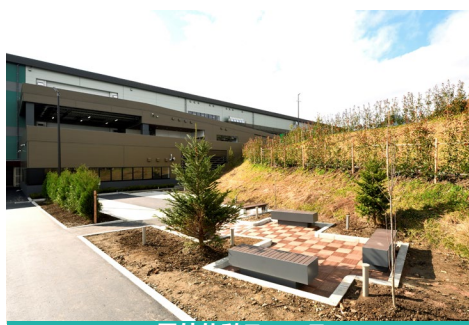
屋外休憩スペース
