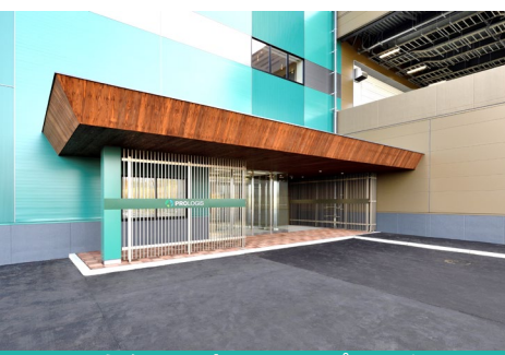
メインエントランスアプローチ
